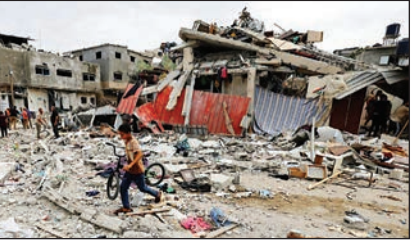
تخریب کامل یک خانه در منطقه شمالی کرانه باختری.
