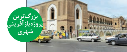
بزرگ‌ترین پروژه باز آفرینی شهری توضیحات: پروژه خانه شهر در ضلع شمالی میدان امام خمینی (ره) قرار گرفته است و می‌توان آن را نخستین و بزرگ‌ترین پروژه باز آفرینی شهری با حفظ ساختار و شکل سنتی نما یا طرحی داخلی مدرن پایتخت دانست. مساحت: ۴ هزار و ۹۰۰ مترمربع زیربنا: ۱۸ هزار مترمربع طبقات: ۲ طبقه روی زمین و ۲ طبقه زیر زمین
