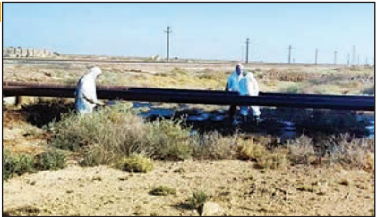
شرح عملیات تعمیر لوله نفت
