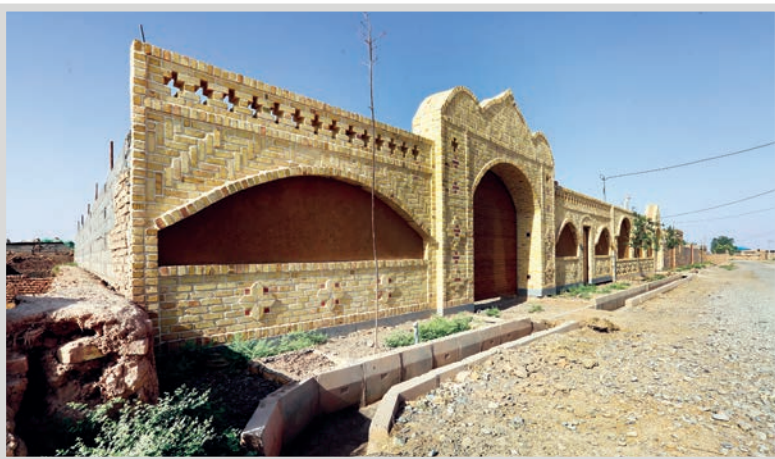
بازسازی نمای خانه‌های قدیمی در روستای سنرد
