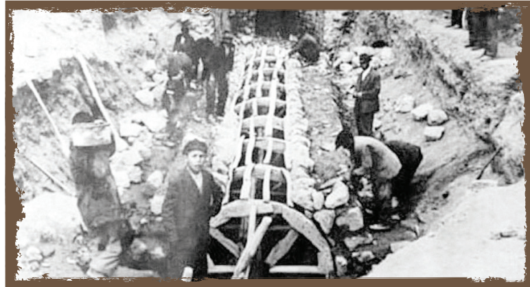
حفر قنات در زمان قاجار
