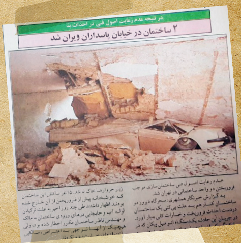
عدم رعایت اصول فنی ساختمان سازی موجب فروریختن دو واحد ساختمانی در تهران شد
