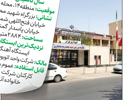
سالن تویی چندمنظوره: ۶۲۵ مترمربع (رشته‌های فوتبال، والیبال، بسکتبال و هندبال) اسکوی تماشاچیان سالن آبی: ۹۵ مترمربع (استخر، سونا و جکوزی) سالن بدنسازی: ۶۰ مترمربع سالن‌های ورزشی هوازی شامل ایروبیک، فیتنس و... پارکینگ: ۲۲۰ مترمربع
