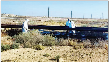
شرح عملیات تعمیر لوله نفت
