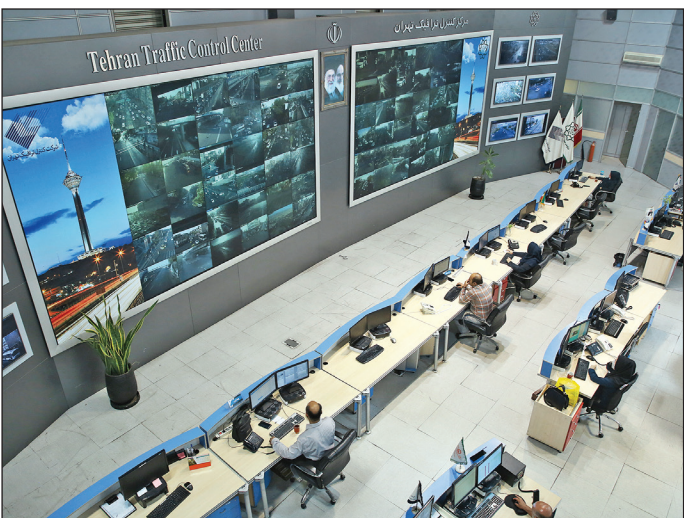
کنترل ترافیک تهران در مرکز کنترل ترافیک تهران
