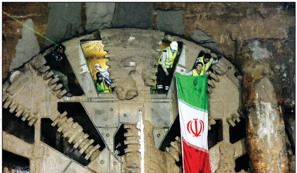
عکس: همشهری / تصویر: ماسیم - ایستگاه حفار خطوط جدید مترو (TBM) از نوع دستگاه‌های قطر بزرگ ۱۵.۷ متری است.
